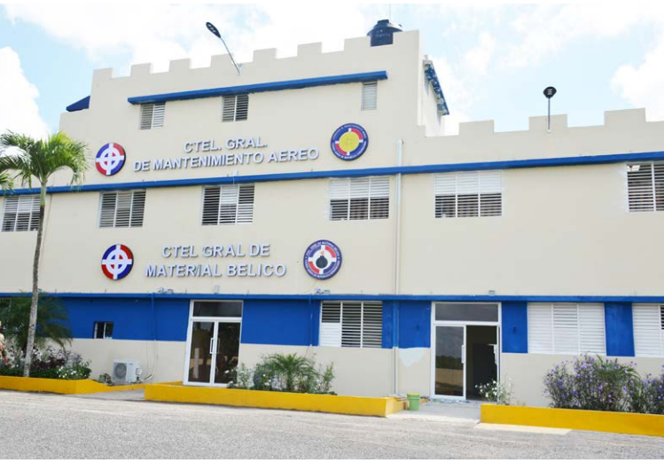
- Remodelación del Cuartel General de Mantenimiento Aéreo,
